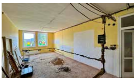
bývalé prostory školní družiny při opravě
