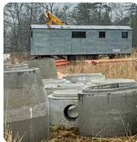
zahájení výstavby inženýrských sítí
