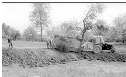
zasypávání vyhrabaných základů pro novou prodejnu
