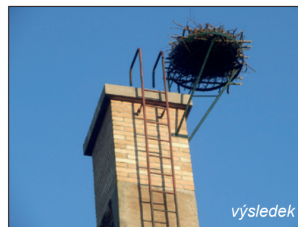
konstrukce na komíně
