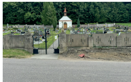
zahájení výstavby chodníku - 23. srpna 2025
