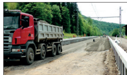
V Lanšperku byla odstraněna manipulační kolej a v tomto prostoru bylo vybudováno nové zvýšené nástupiště (vpravo). Úplně nové nástupiště vznikne na levé straně mezi 1. staniční kolejí a stávající cyklostezkou. Foto: Petr Buryška
