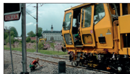
NOVÉ KOLEJE v okolí Letohradu se objevily v polovině května. Na přejezdu „u pily“, s dominantou letohradského zámku v pozadí, upravuje automatická strojní podbiječka směrovou a výškovou polohu koleje. Foto: Petr Buryška
