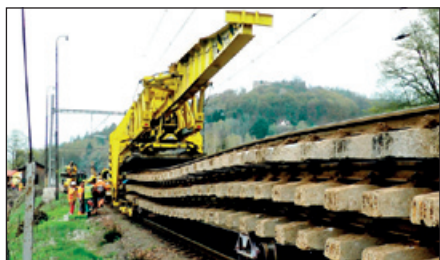
Pokladač PKP 25/20 likvidoval kolejová pole od Lanšperka směrem k Ústí n. O. je instalován na automobilu Tatra a kolejová pole trhá pod sebou a nakládá na podvozky před sebou, které pojíždějí ještě po stávajících kolejích. Zřícenina hradu Lanšperk pak dodává autentičnost místopisu záběru. Foto: Petr Buryška
